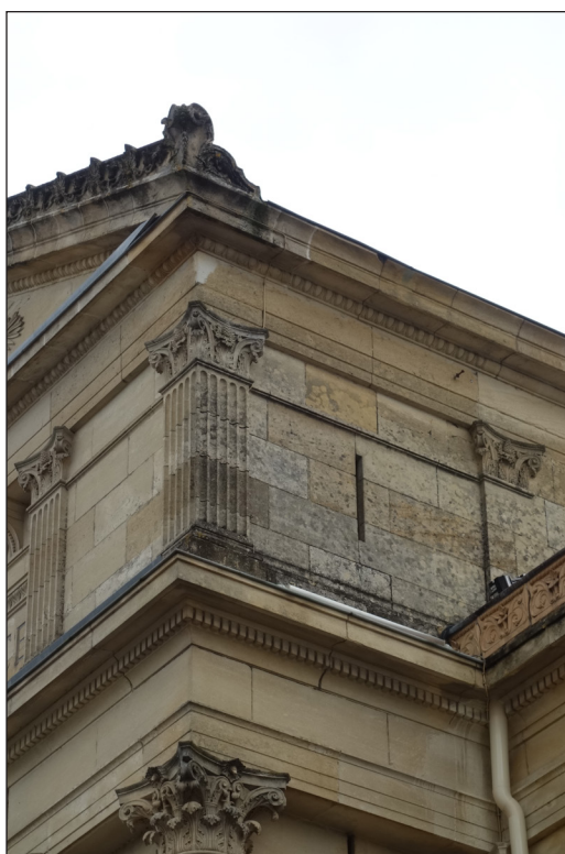
Agen (47) - Palais de Justice - Angles supérieurs Nord-est et Nord-ouest du porche montrant des traces de débordement EP. (Parties non inspectées lors de l'étude).
