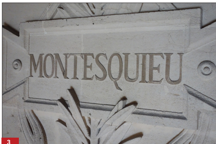
3 Agen (47) - Palais de Justice - Vues comparative entre une des inscriptions du niveau d'entablement passée et ternie et la bronzine or bien conservée du linteau de la première chambre. Les coulures noires de part et d'autre du chambranle seront à éliminer.
