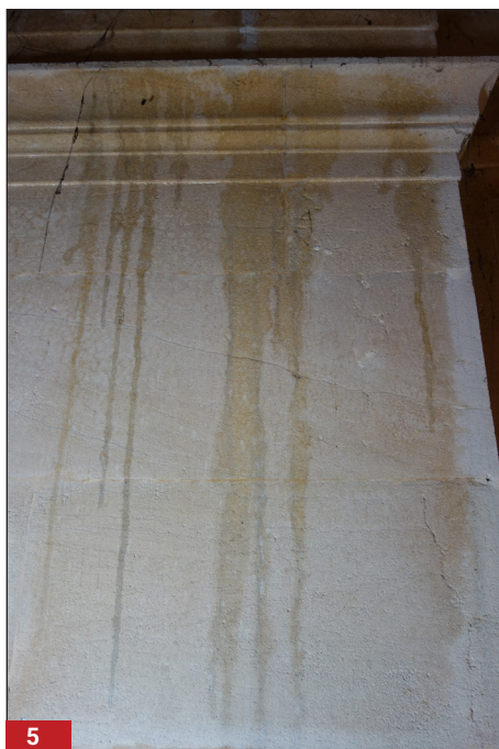
Agen (47) - Palais de Justice - Angle Nord-est de l'élévation Est. Vues d'ensemble de la zone retenue pour réalisation des essais de nettoyage par application de compresses et cataplasmes.
