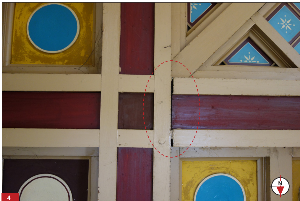
Agen (47) - Palais de Justice - Angle Nord-est du plafond à caisson du hall d'entrée avec marque de mouvement au niveau du raccordement entre deux poutres de l'ossature primaire. En haut à gauche et en bas à droite de l'image figure l'exemple de état actuel disgracieux de la couche picturale des fonds unis jaune havane
